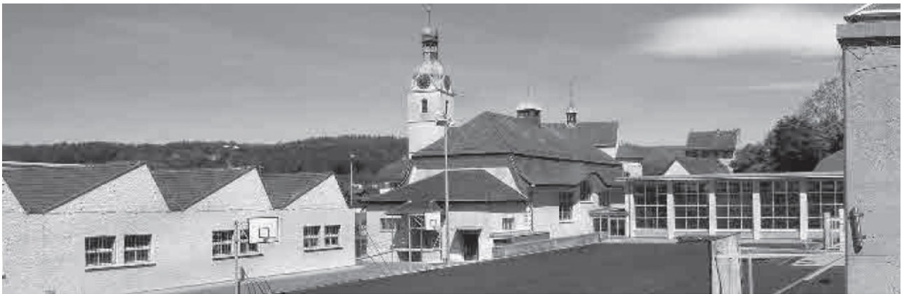
Abb. 7: Ansicht Schulareal mit Shedhalle und Turnhallen, Ortsbildaufnahme: (DE) ISOS_3200 Schönenwerd-Niedergösgen, 2009
